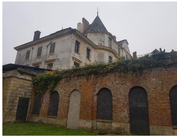
Façade nord et caves
