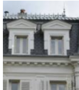
Toiture à la Mansart, lucarnes sur versant à fronton maçonné, volets à persiennes
