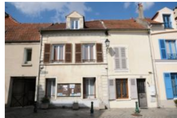
La façade est protégée par un enduit, les fenêtres sont à grands carreaux avec des volets à persiennes.
