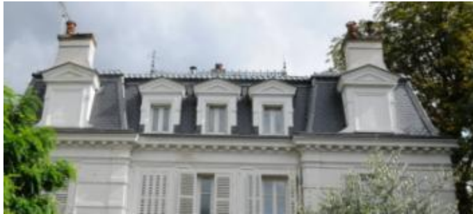
Toiture à la Mansart, lucarnes sur versant à fronton maçonné, volets à persiennes
