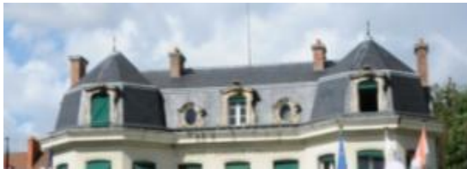
Toiture à la Mansart, lucarnes sur versant à fronton maçonné, volets à persiennes
