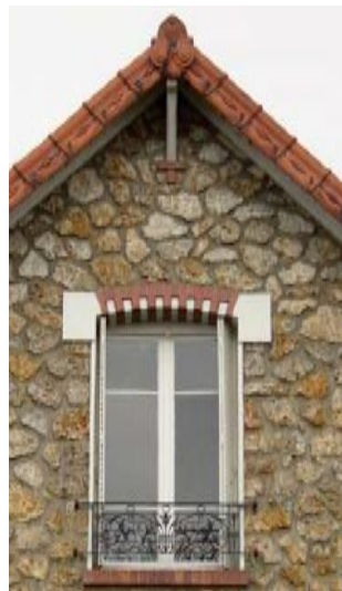
Grande diversité dans les détails, modénature et encadrements des fenêtres : briques, céramiques, pierres.
