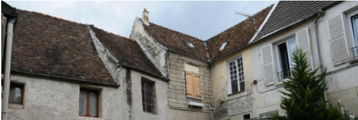
Un jeu de toits sur cour, avec des tuiles plates typique des cours communes
