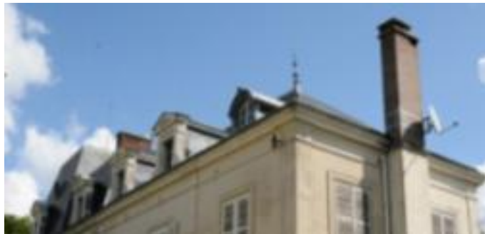
Chaînage d'angle en pierre, marquise en ferronnerie
