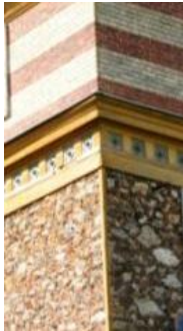
Grande diversité dans les détails, modénature et encadrements des fenêtres : briques, céramiques, pierres.
