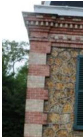
Grande diversité dans les détails, modénature et encadrements des fenêtres : briques, céramiques, pierres.
