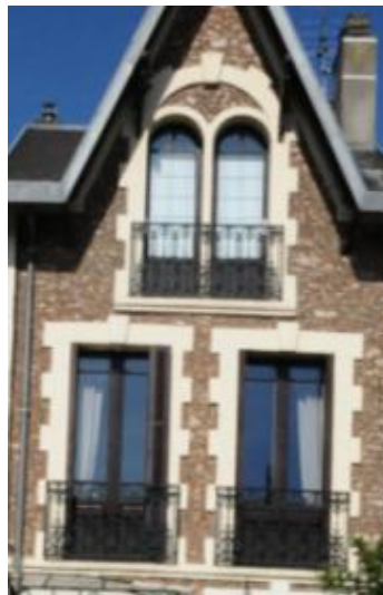
Grande diversité dans les détails, modénature et encadrements des fenêtres : briques, céramiques, pierres.
