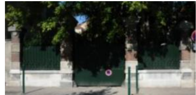
Mur bahut avec grille, piliers en briques et pierres
