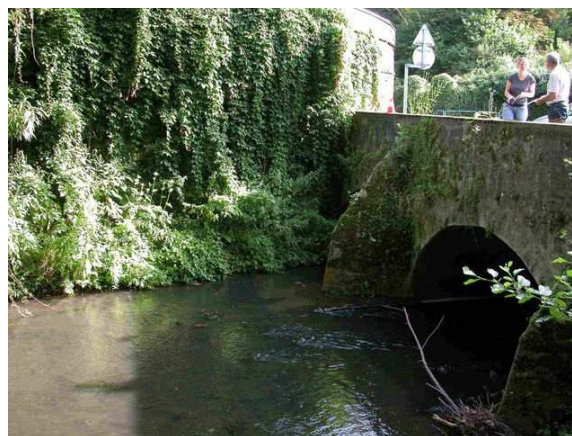
Vue aval du point de prélèvement
