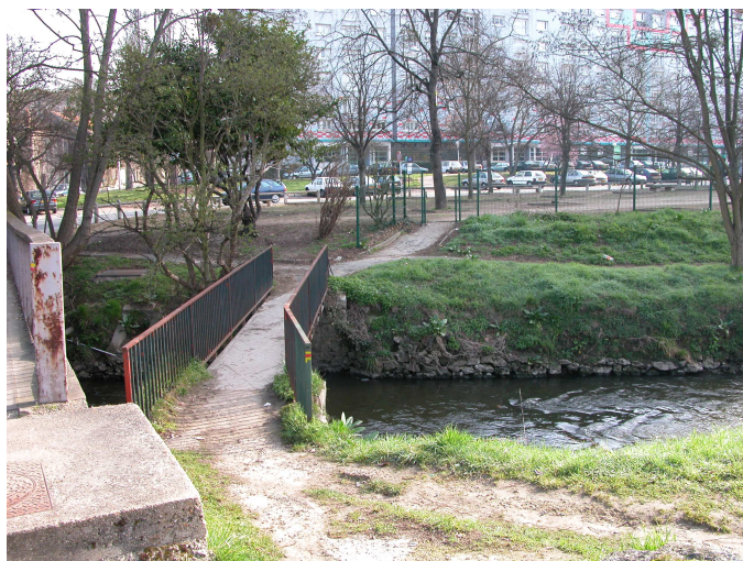
Vue générale d'accès à la station
