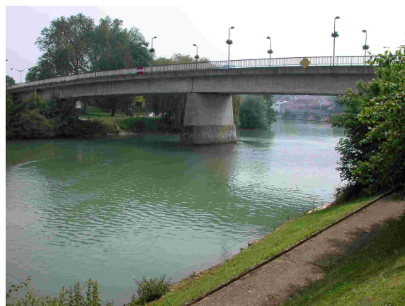
Vue aval du point de prélèvement
