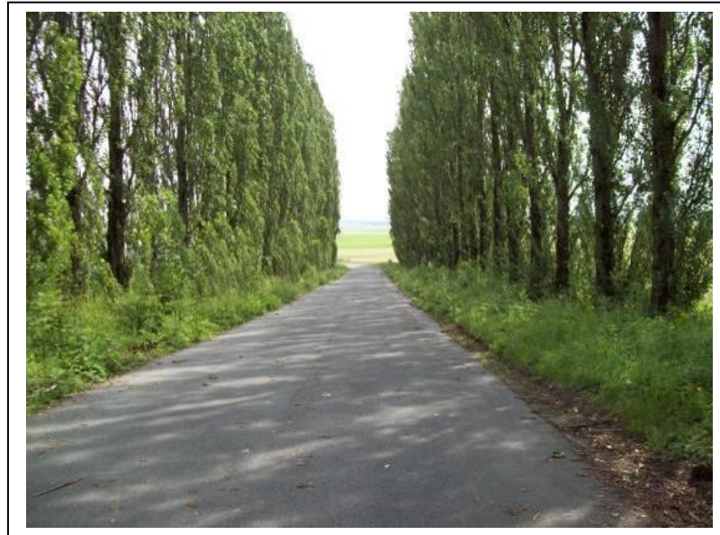
Vue de la voie d'accès au site
