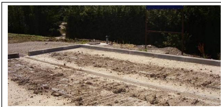
Dalle étanche de remplissage des réservoirs
