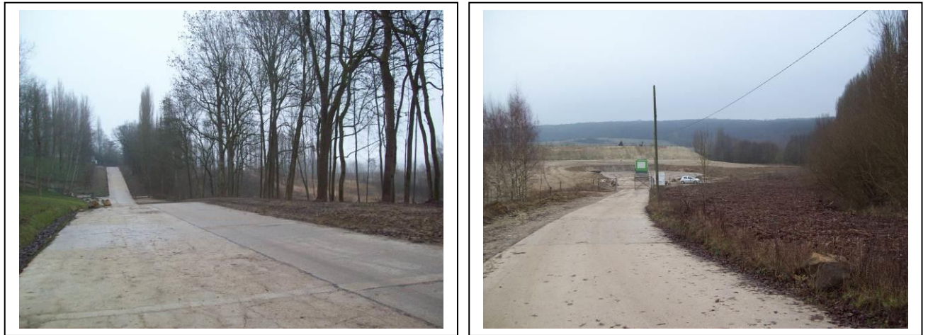
Vue de la voirie intérieure au site et à la zone d'exploitation de l'ISDI
