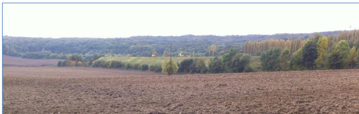
Vue du merlon paysagé en phase finale de réalisation – Octobre 2013
