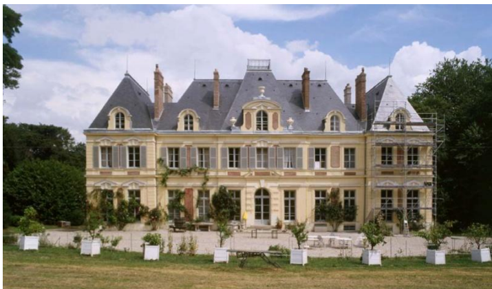
(75) Château du Faÿ - source : base Mérimée
