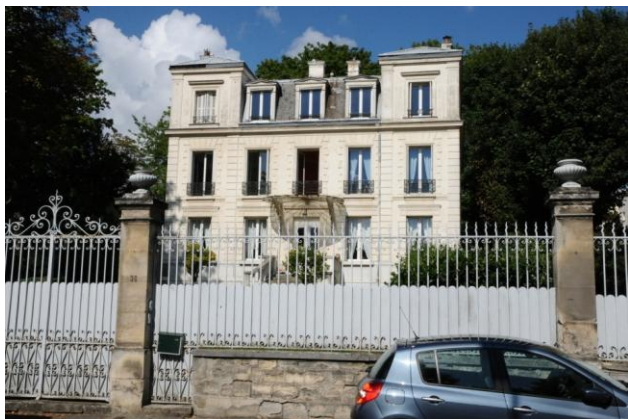
(21) – Maison de notable et bâtiment de commun
