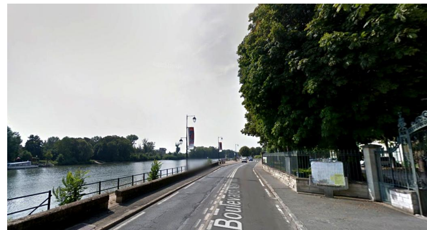
Boulevard Noël Marc - source : google street
