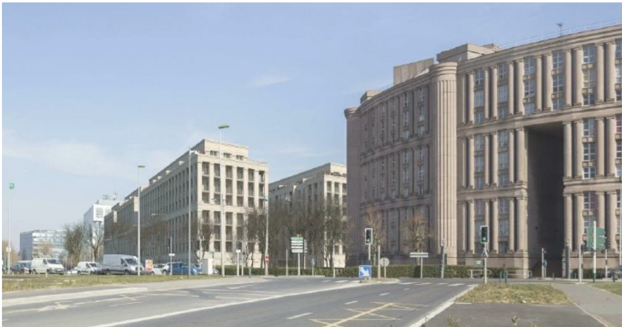
Illustration 7: vue sur l'îlot nord et les bâtiments existants (source : étude d'impact - page 270)
