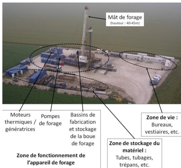
Figure 7 : Environnement d'un appareil de forage
