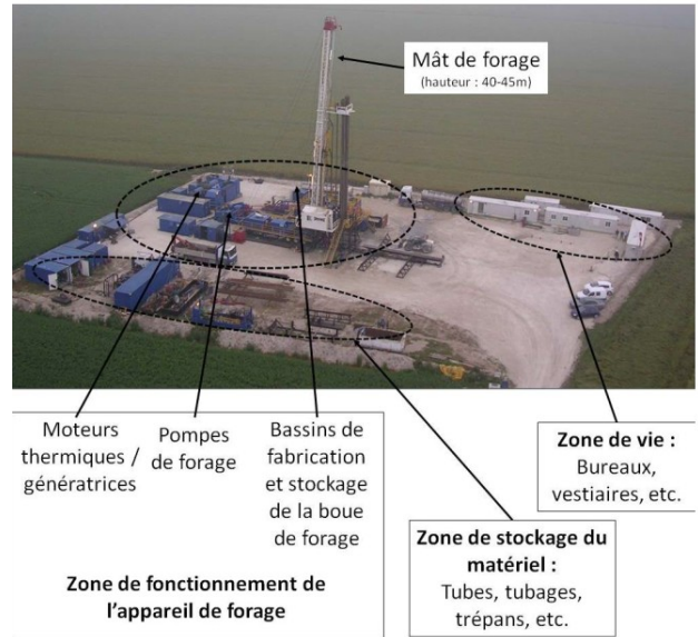
Figure 7 : Environnement d'un appareil de forage
