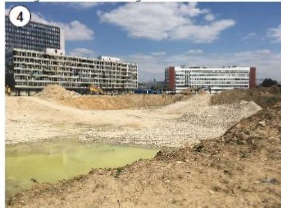
Figure 33 : Ancienne emprise du bâtiment TNT
