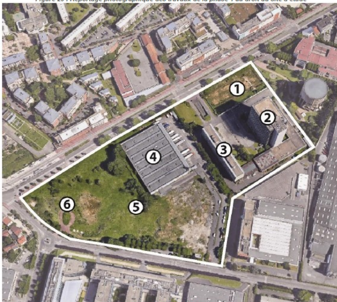
Figure 29 : Reportage photographique des travaux de la phase 1 au droit du site d'étude
