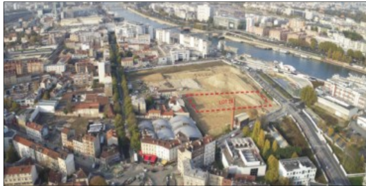
Figure 4 - Photographie aérienne du site après démolition (Source : étude d'impact p.15)
