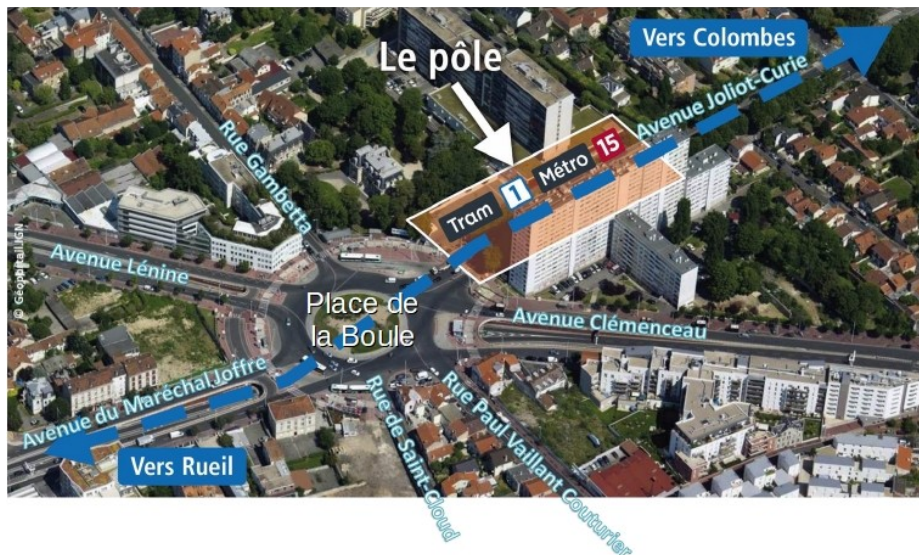
Illustration 7: Tram 1 et gare de la ligne 15 du Grand Paris Express place de la Boule à Nanterre (source : chapitre II, p. 38)
