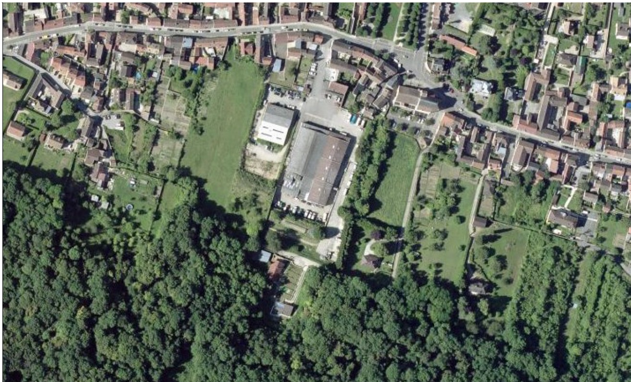
Illustration 1 bis : vue aérienne du site
