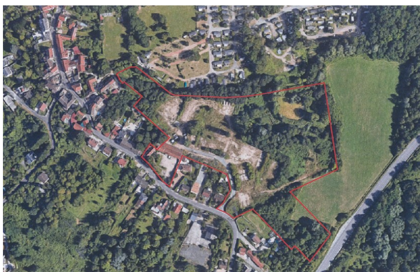
Illustration 2: photographie aérienne du site – source : étude d'impact p.13
