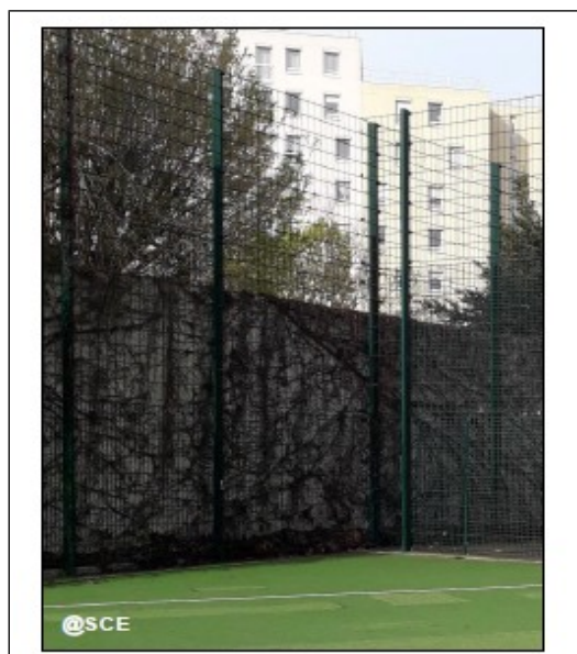
Illustration 7 : Vue du mur à interstices (Ei p.45)
