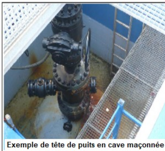
Illustration 11: Maçonnage d'une tête de puits - Source Compagnie Française de Géothermie
