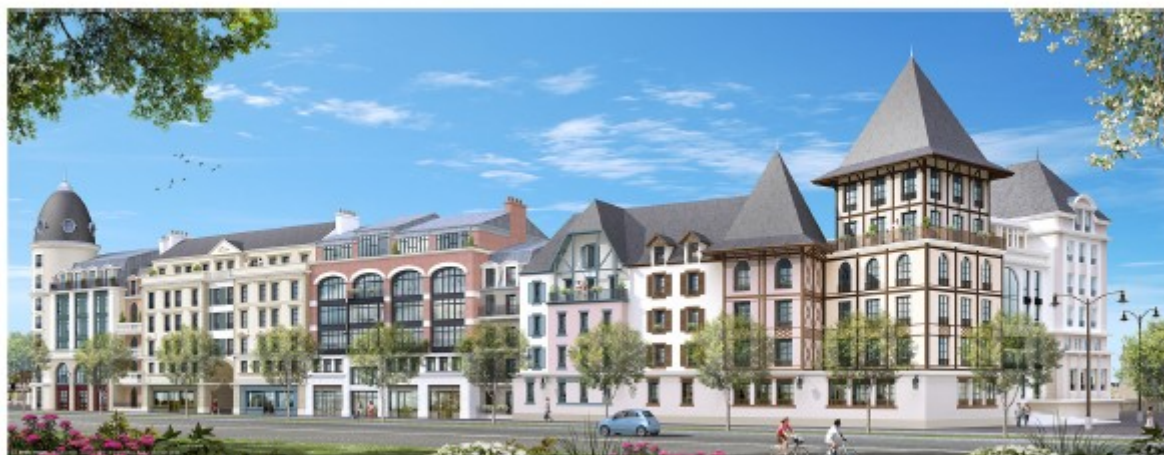
Les façades du projet global sur le carrefour et l'avenue du 8-Mai-1945
