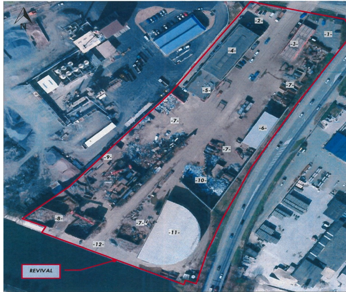
Illustration 1: Vue aérienne du site actuelle. Source : « Présentation de l'activité » p.84. NOTA : les illustrations ne sont pas toutes orientées de la même manière et sont hors échelle
