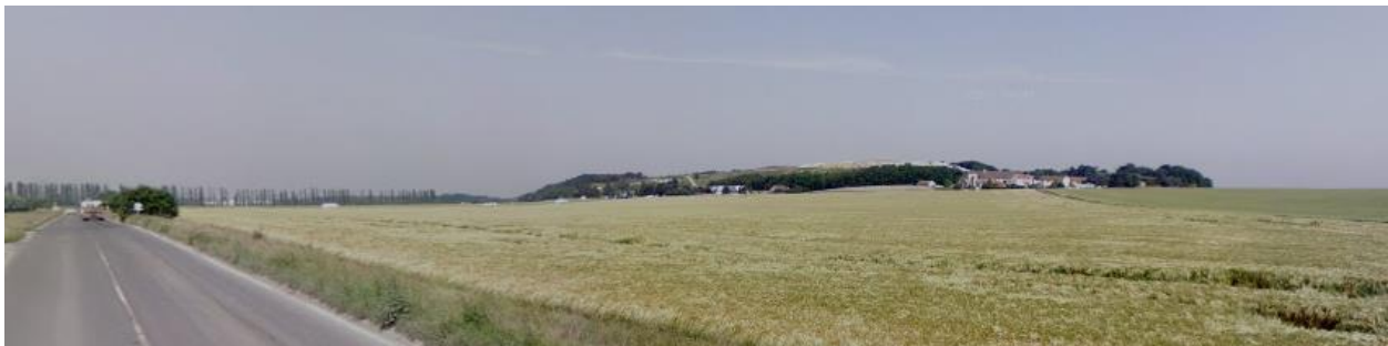
Figure 3 : Vue lointaine du site depuis le sud est
