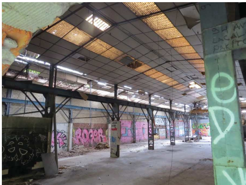
Photographie 25 : Intérieur du hangar, depuis une ouverture dans la façade arrière (1).
