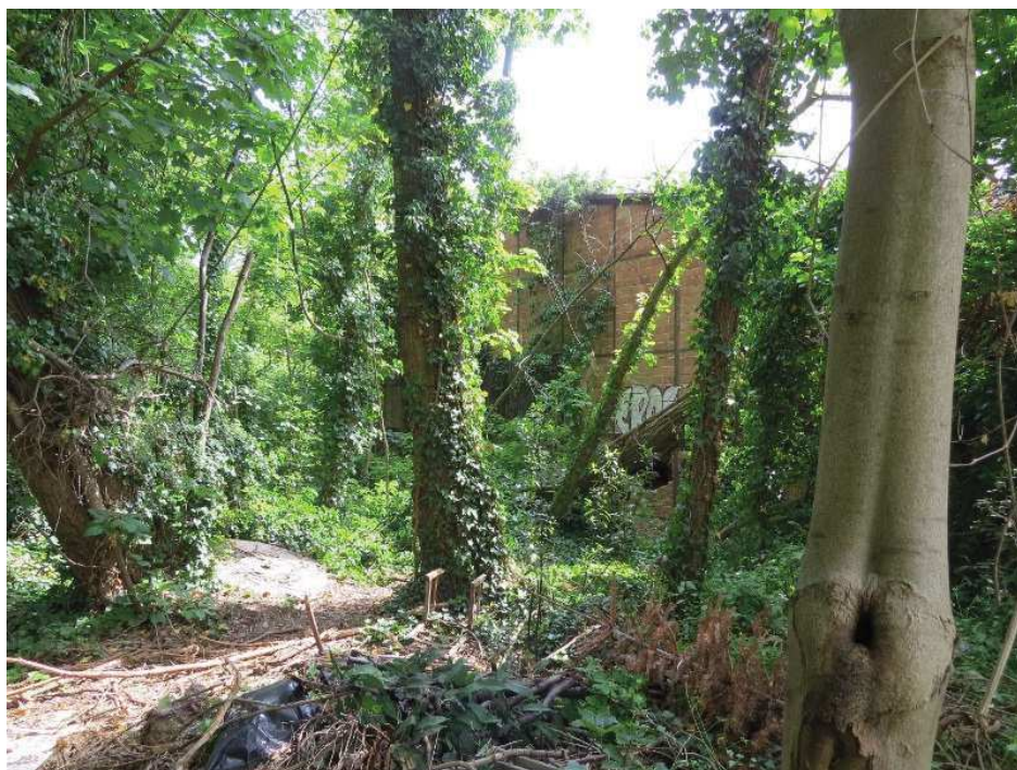
Photographie 23 : Façade arrière du hangar à démolir
