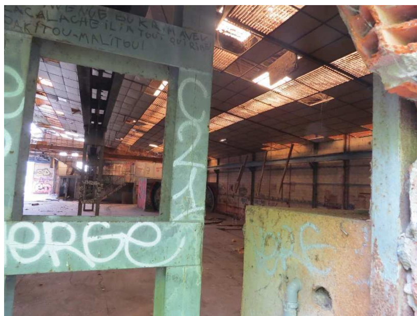
Photographie 27 : Intérieur du hangar, depuis une ouverture dans la façade arrière (3).
