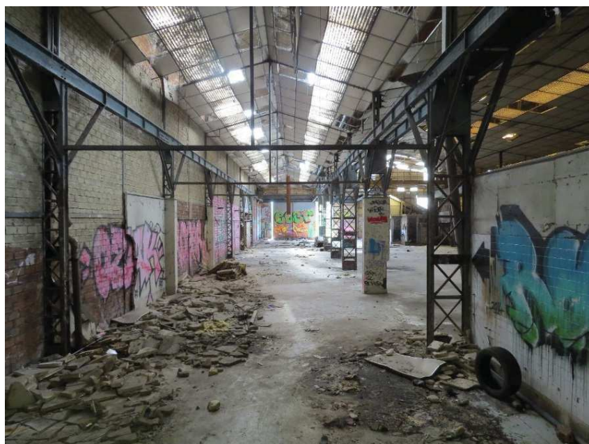
Photographie 26 : Intérieur du hangar, depuis une ouverture dans la façade arrière (2).
