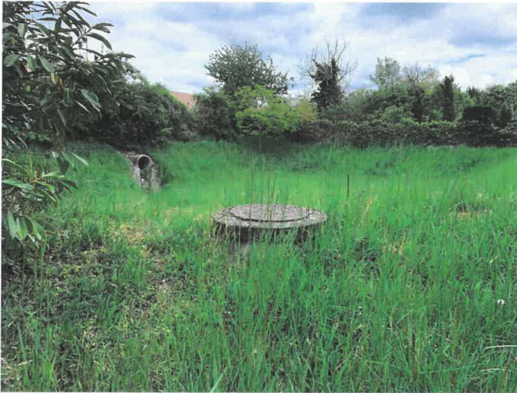
Photographie 3 : Bassin de retention
