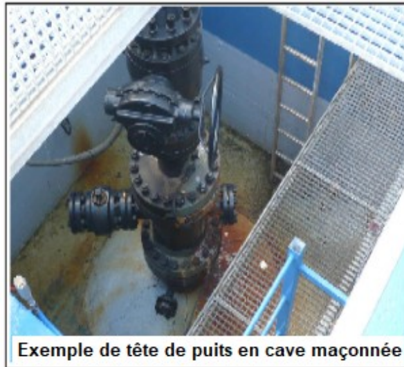
Illustration n° 10 : Maçonnerie d'une tête de puits - Source Compagnie française de géothermie
