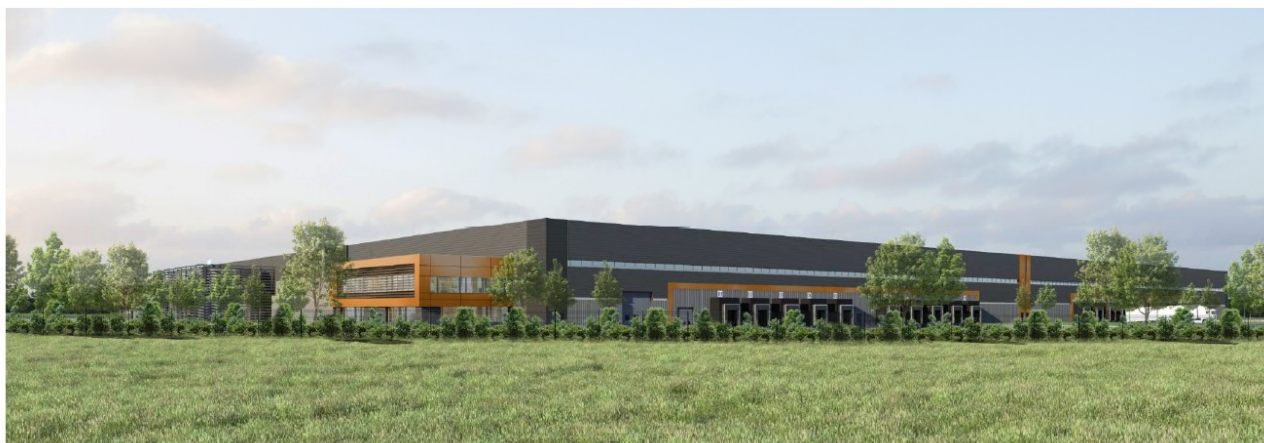
Illustration 6: Insertion paysagère de l'entrepôt. Source : étude d'impact p.101.
