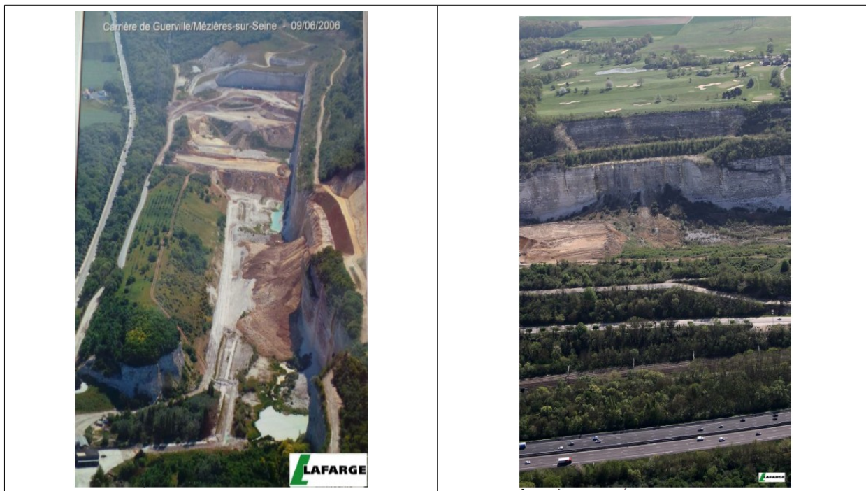
Illustration 8 : Photographies aériennes du secteur d’effondrement de 2001
