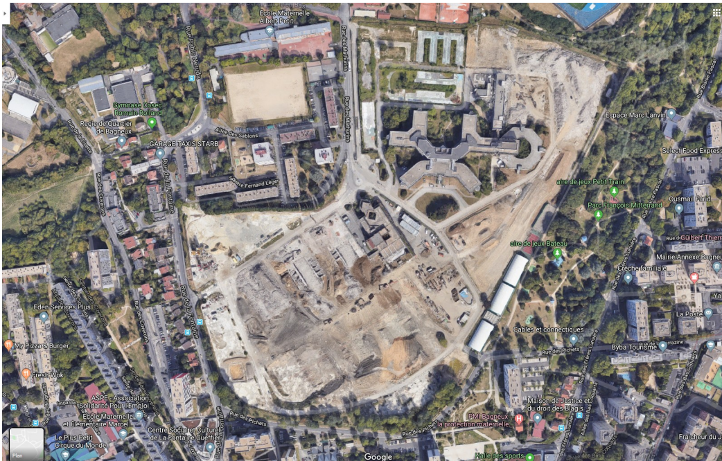
Figure 3: vue aérienne du site des Mathurins en janvier 2020
