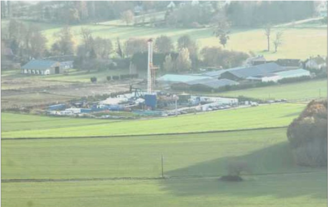
Figure 82 : Phase d'aménagement/forage : mât de forage (Nonville 2014)
