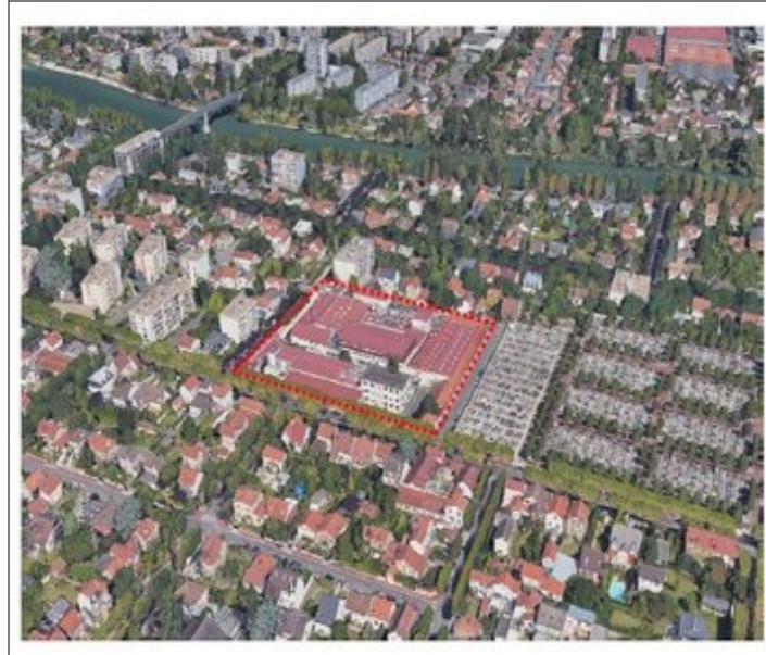
Vue du site et de ses abords (source : Étude d'impacts – p.113)
