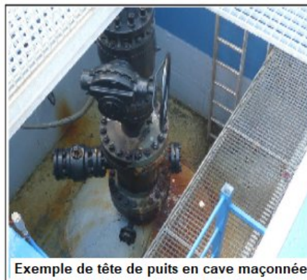
Exemple de tête de puits en cave maçonnée Illustration 10 : exemple de tête de puits géothermal en cave maçonnée Source DRIEE
