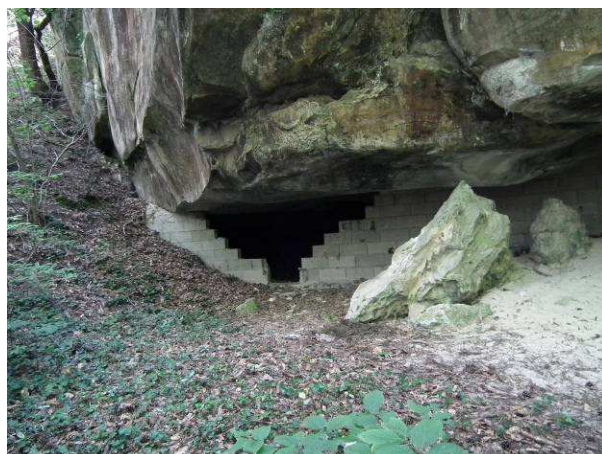
Mur en parpaings vue depuis l'extérieur
