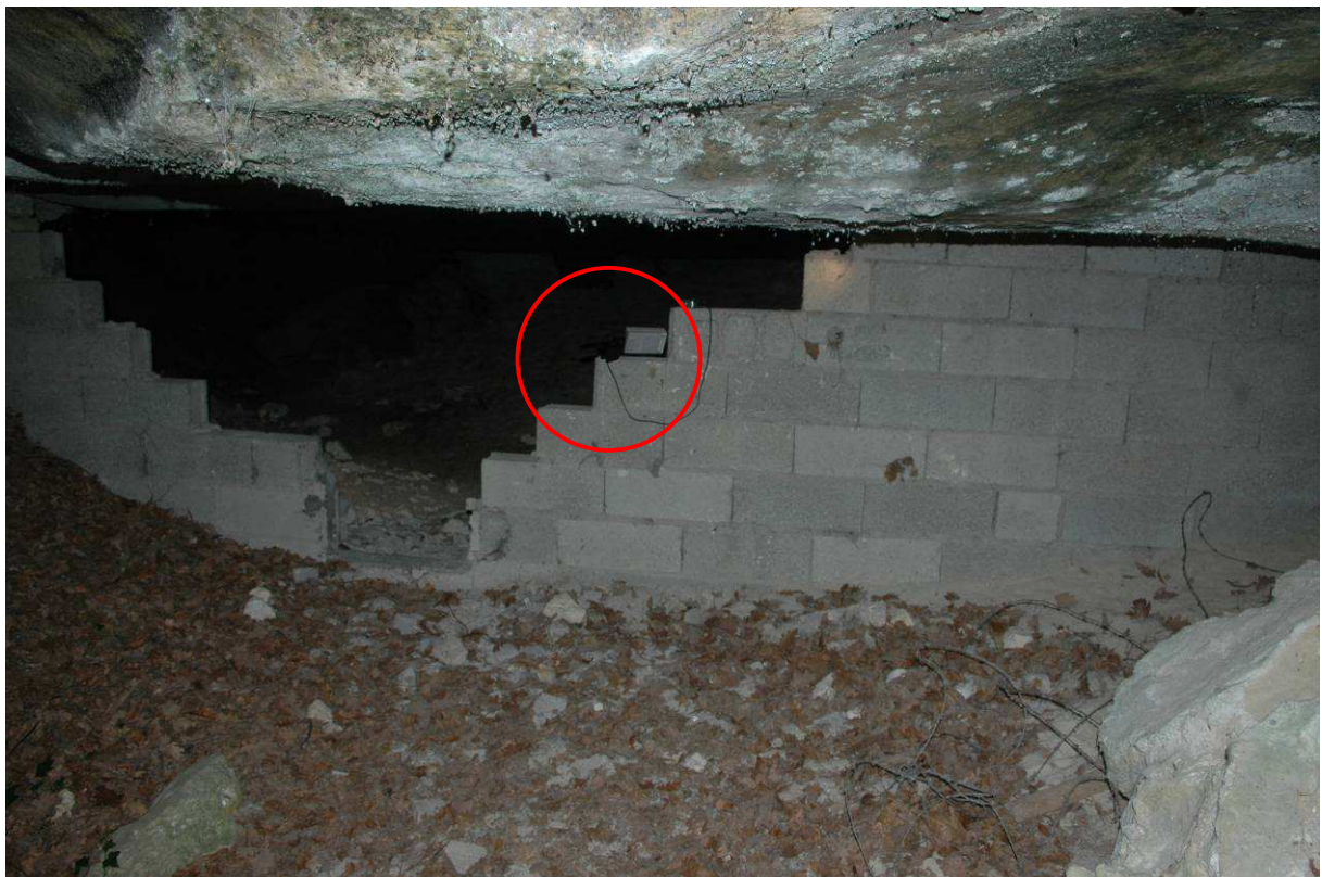
Positionnement du détecteur au niveau de l'entrée 1A (côté château)
