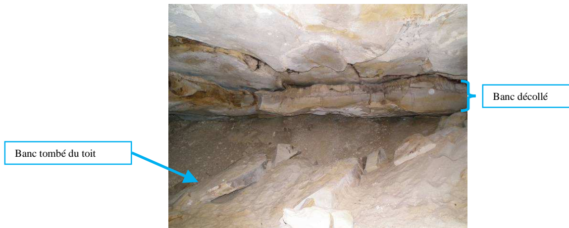
Décollement de banc de grès
