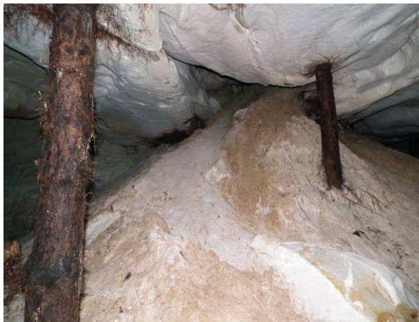
Déboufrage au niveau d'une cheminée naturelle
