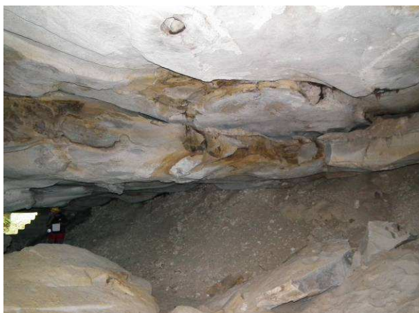
Remblais en carrière au niveau de l'entrée
