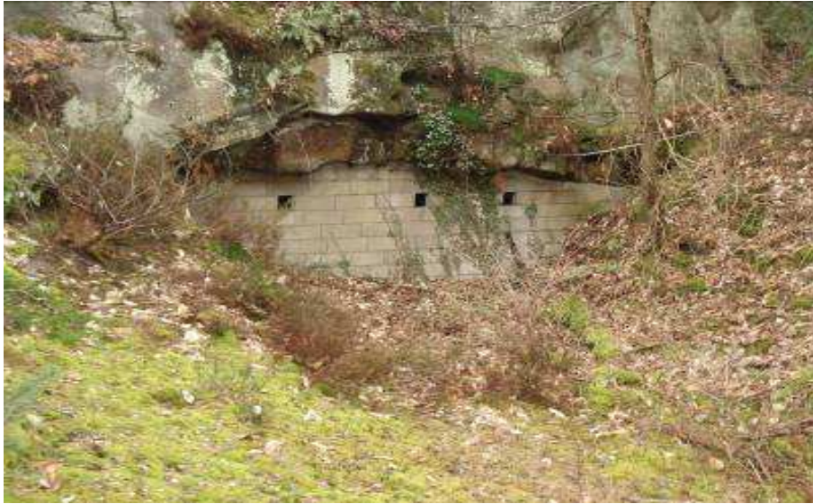
Mur avec ouvertures - entrée 3, carrière principale. © A.Houstin- Mars 2010
