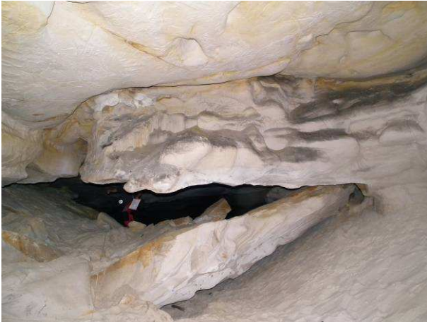
Masse de grès (7 à 10 m 3 ) éboulée, partiellement recouverte de sable
