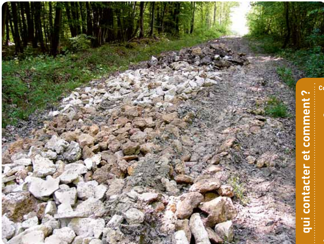
Remblai d'un chemin par dépôts de pierres © Biotope
