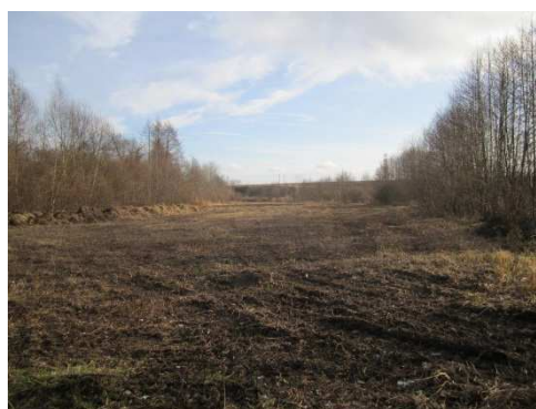
La mégaphorbiaie après travaux (Novembre 2013)
