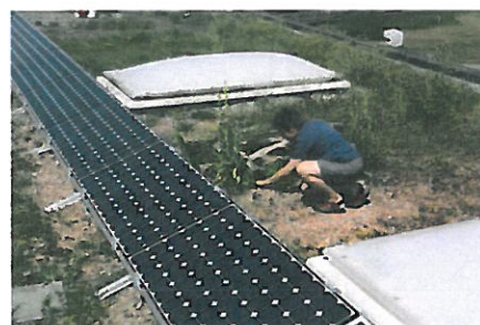
Illustration de toitures extensives combinée au panneau solaire (Source : ZHAW, 2011 )
