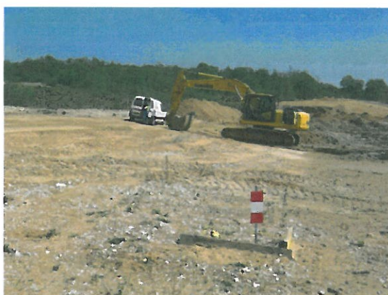
b) Repérage d'un nid avec marquage visuel avant chantier de terrassement
