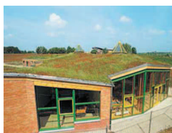
Photo 78 : Exemple de toit végétalisé
