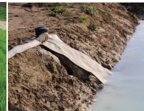
Photo 53 : Membrane de protection au niveau du rejet des eaux dans le bassin de décantation (Source : SYSTRA, 2012)
