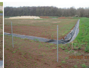
Photo 51 : Clôtures et fossés autour des installations de chantier (Source : SYSTRA, 2012)
