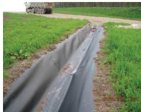
Photo 52 : Réseau d'assainissement provisoire avec bâche en plastique (Source : SYSTRA, 2012)
