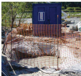
Photo 71 : Exemple de fosse à béton (Source : SYSTRA, 2012)
