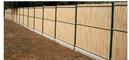
Photo 63 : Exemple de panneaux de bois mis en place sur des clôtures de type Békafix
