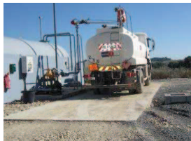
Photo 68 : Exemple de zone étanche pour le ravitaillement des véhicules en carburant (Source : SYSTRA, 2012)
