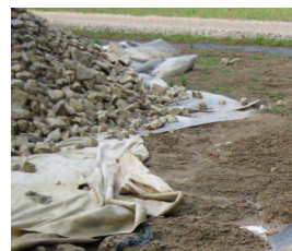
Photo 50 : Bâches au niveau des zones de stockage (Source : SYSTRA, 2012)
