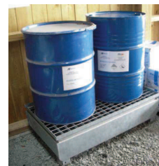
Photo 70 : Produits polluants stockés sur des bacs de rétention (Source : SYSTRA, 2012)
