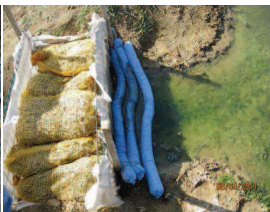
Photo 56 : Association d'un filtre en paille et d'une membrane géotextile (Source : SYSTRA, 2012)
