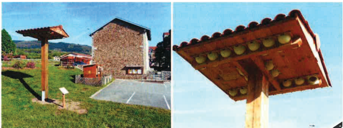
Figure 5 : Exemple de tour à Hirondelles d'une capacité de 30 nids réalisés en chanvre et en chaux et mise en place par le CPN le Colibri, sur la commune de Roisey (Rhône-Alpes) (photos : CPN le Colibri)
