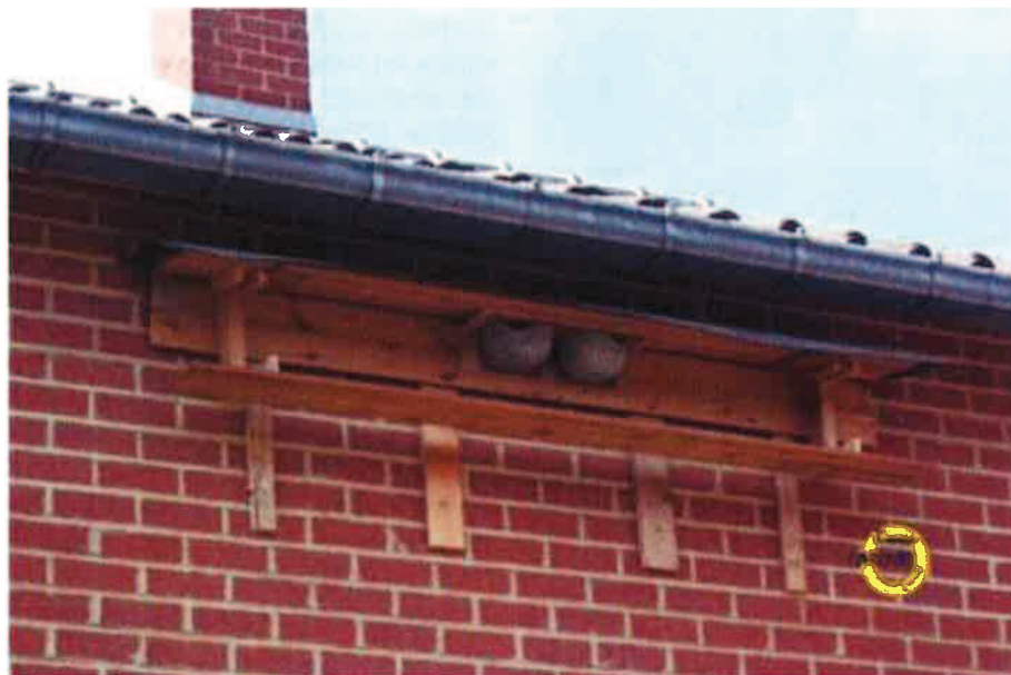
Figure 8 : Exemple de fausse corniche de 2 m de long associée à un double nid artificiel à Hirondelles de fenêtre et à une planche anti-fientes.
