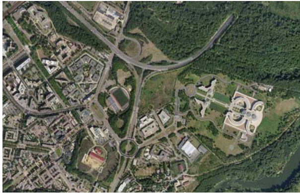
Vue aérienne orthophoto de l'échangeur actuel
