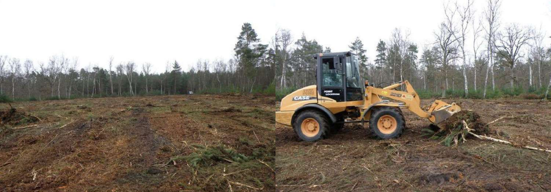
Évacuation des résidus de broyage avec un tracto-pelle.
