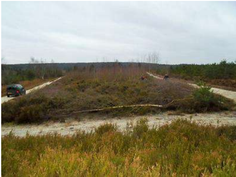
Parcelle 02-22, vue d'ensemble des travaux
