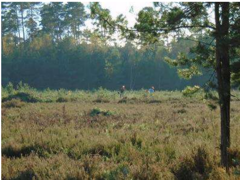
Parcelle 01-33, début des travaux
