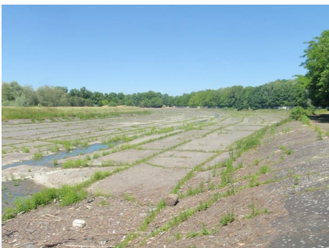
La partie bétonnée du bassin des Brouillards ne présente aucune potentialité d'accueil pour le Blongios nain.
