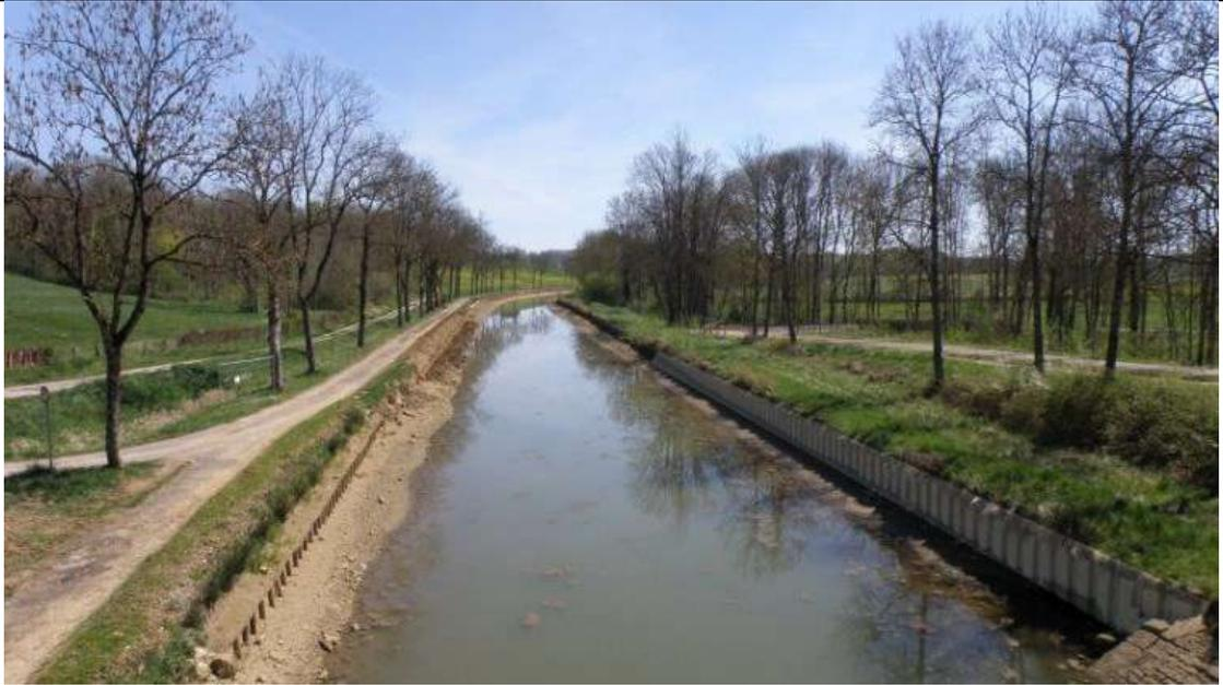
Exemple de réaménagement des berges du canal de Champagne en Bourgogne. A gauche, la technique végétale et à droite la technique de pose de palplanches. Source - chemindeleau.com association loi 1901
