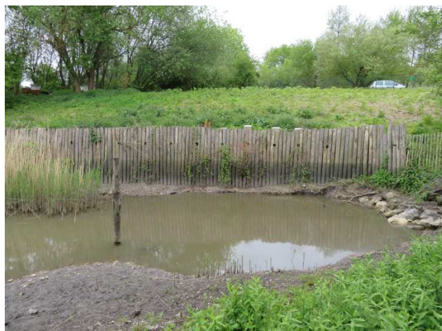
Une dizaine de cavités artificielles a été aménagée dans les palplanches de la zone humide du Roideau
