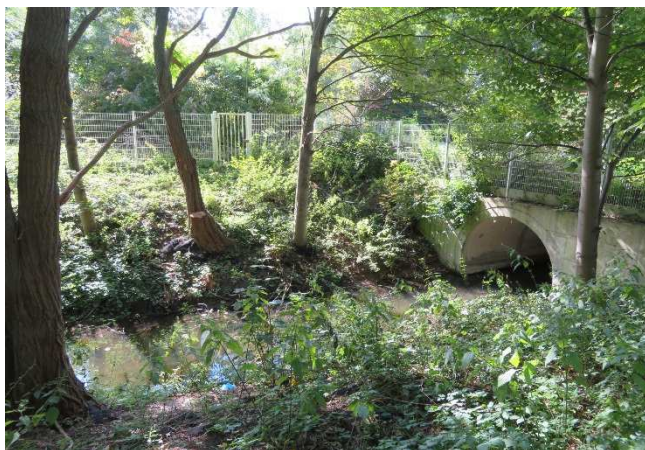
L'accès aux bassins de rétention par le canal permettrait au Martin-pêcheur de trouver une certaine quiétude (secteur grillagé).
