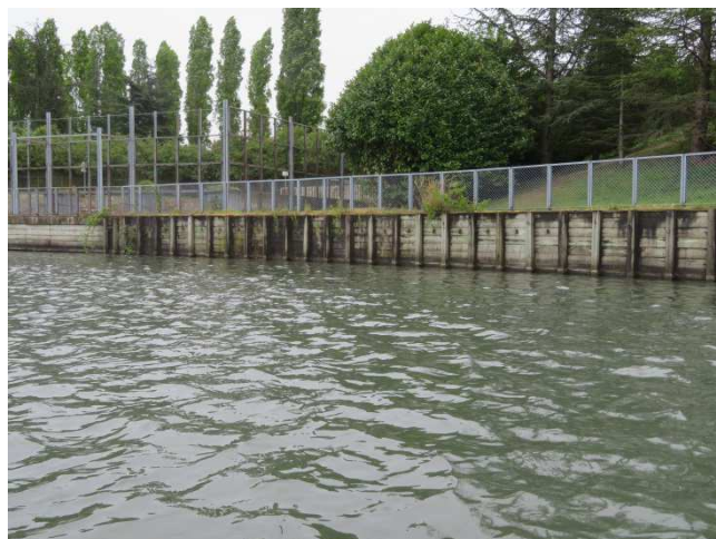
Berges aménagées par des palplanches
