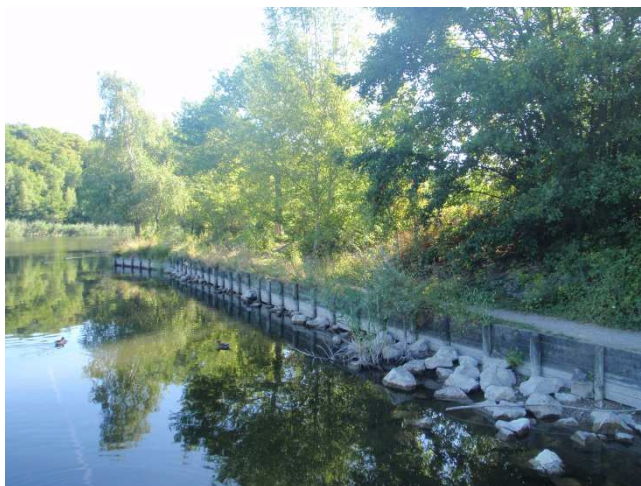
La berge sud est bordée d'une promenade sur un talus renforcé par des palplanches en bois et blocs de pierres. Le dérangement et l'effarouchement sont forts. Un aménagement dans ce secteur n'est pas envisageable.
