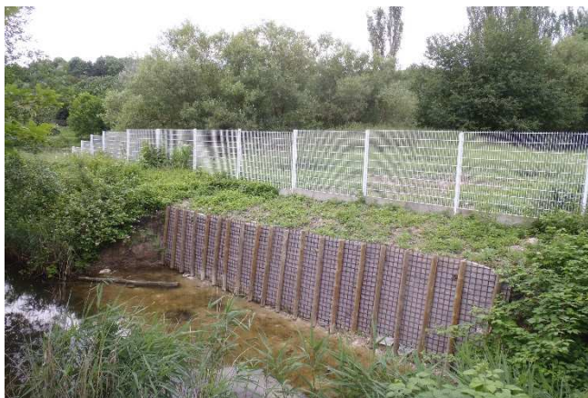
Les berges du canal ont été aménagées en 2012 pour favoriser la nidification du Martin pêcheur d'Europe. Source : ECOTER, 2012
