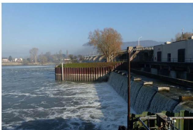
Vue aval de la centrale
