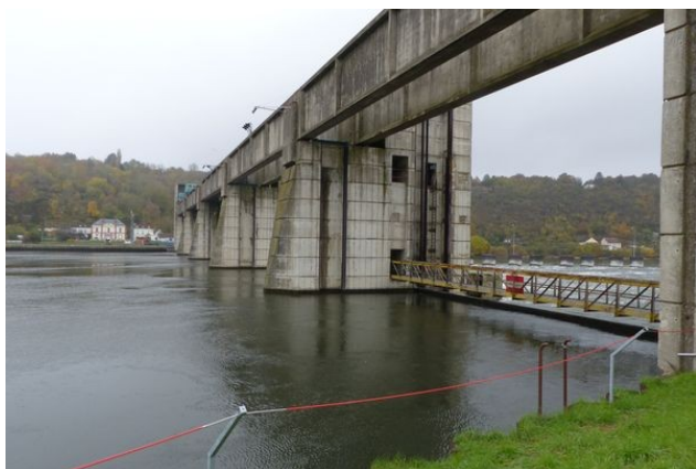
Vue des ouvrages de décharge
