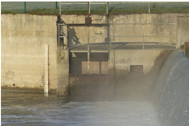
Vue entrée passe à montaison
