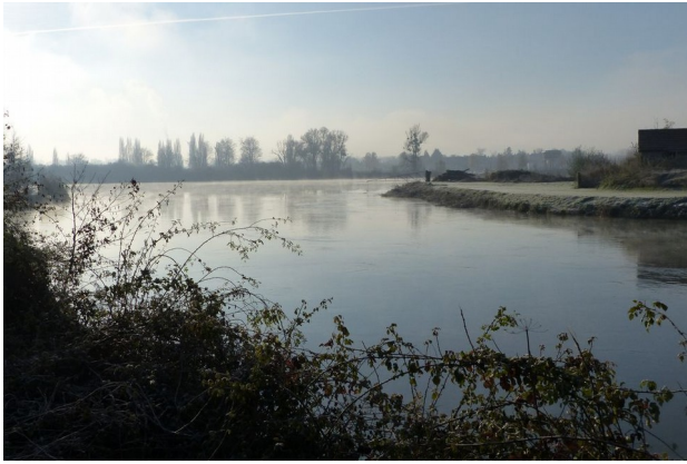
Vue de l'entrée du canal d'amenée à la centrale
