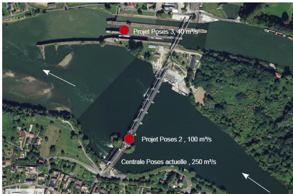
Vue aérienne du barrage de Poses, source : géo-portail, novembre 2016
