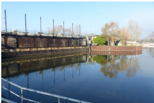
Vue de l'amont de la centrale
