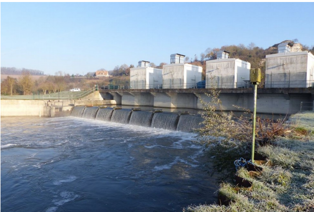
Vue aval de la centrale
