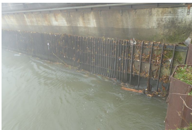
Zoom sur la grille de la prise d'eau au niveau de l'exutoire de dévalaison en rive droite
