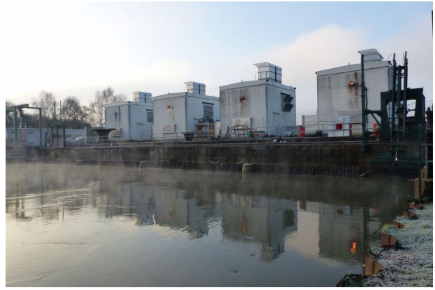
Vue de la prise d'eau en rive droite
