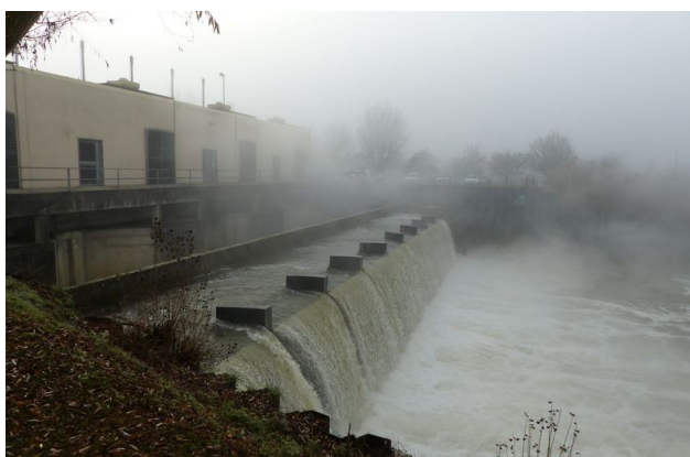
Vue aval : dispositif d'oxygénation
