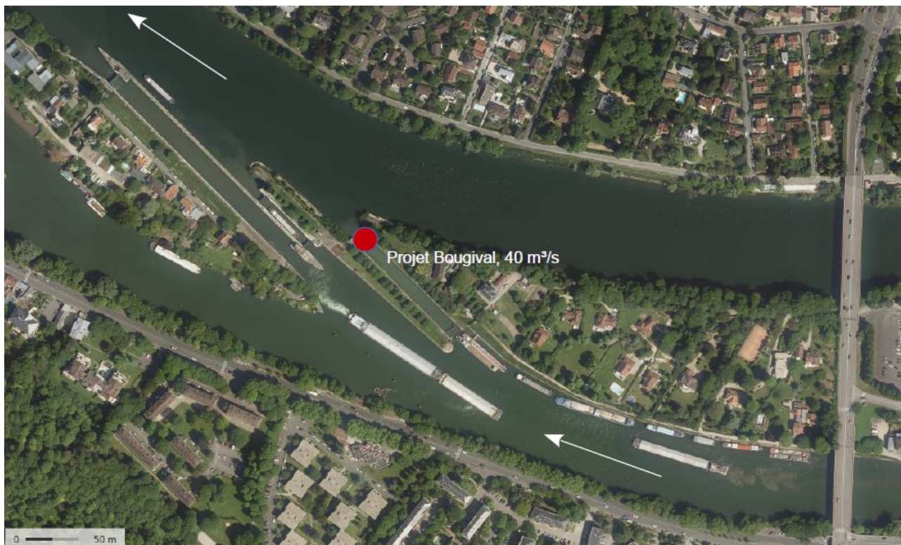
Vue aérienne du barrage de Bougival, source : géo-portail, novembre 2016
