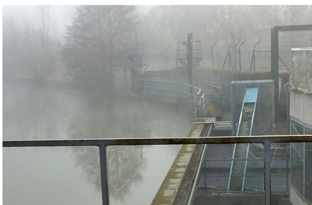
Vue volet amont de la passes à anguille
