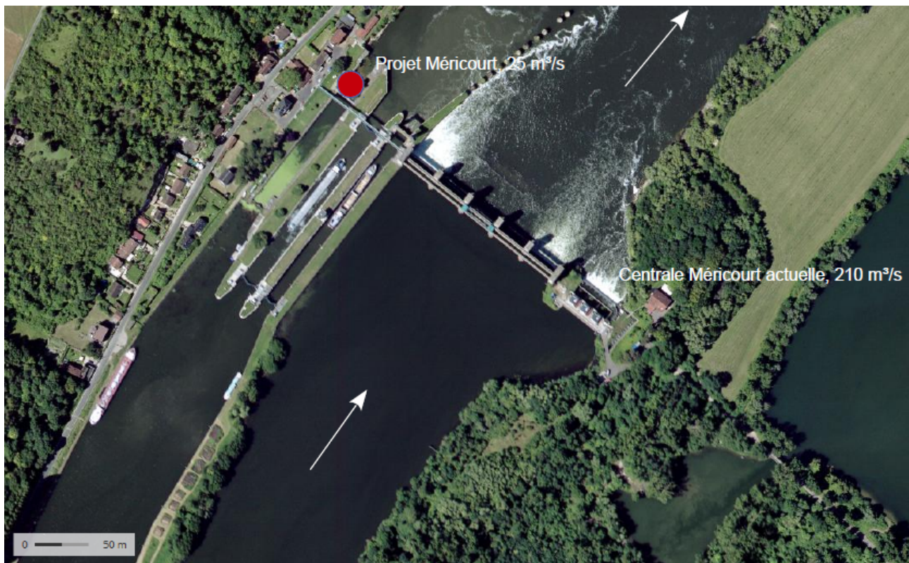
Vue aérienne du barrage de Méricourt, source : géo-portail, novembre 2016
