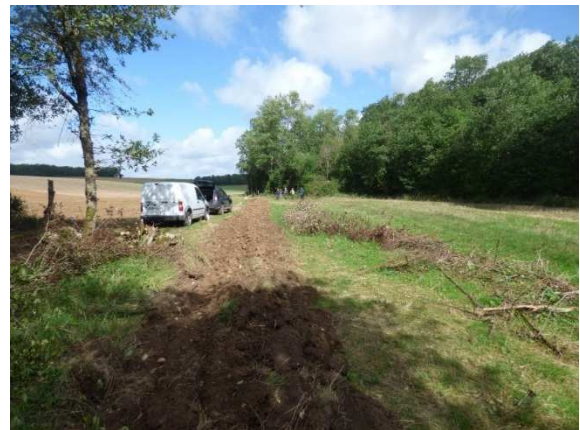
Figure 7. Travaux de remise en état du chemin, septembre 2017.
