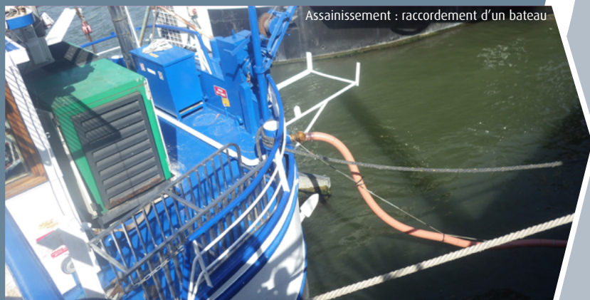
Assainissement : raccordement d'un bateau
