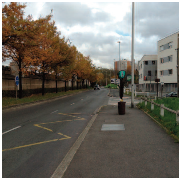
Sur l'ex-RN186, le long de la couverture de l'A86 à Bobigny
