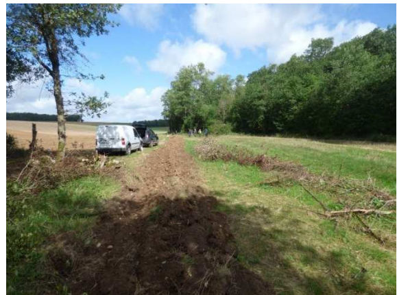
Figure 7. Travaux de remis en état du chemin, septembre 2017.
