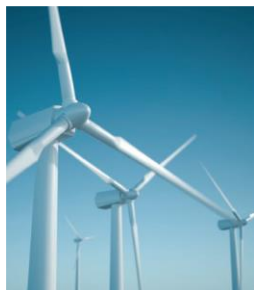
Les pales d'éoliennes contiennent des fibres de verre, du kaolin
