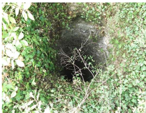
Cheminée d'aération de la cavité. ©Biotope
