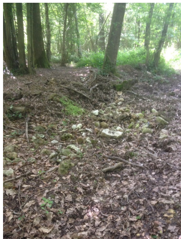
Figure 14 : Comblement d'ornières au Bois des Brûlis
