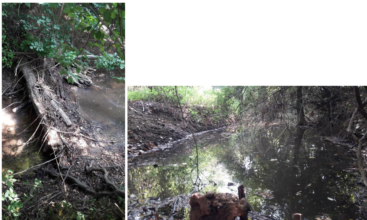
Figure 23 : Barrage en bois et rivière impactée par la retenue
