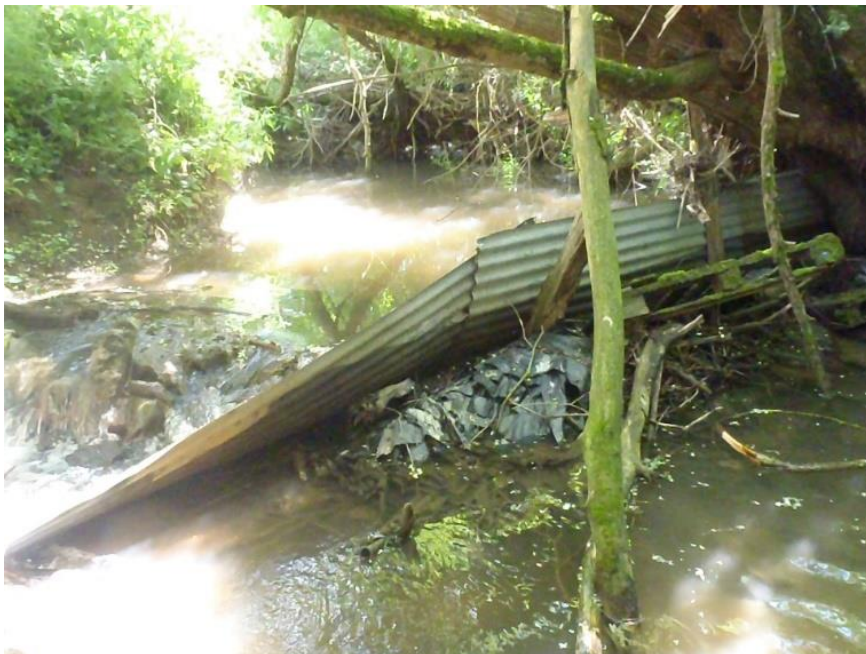
Figure 21 : Barrage détruisant les habitats de mulette épaisse, 2017
